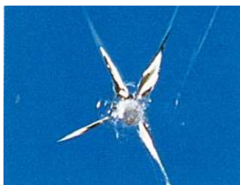
極めて細かい星型の亀裂
