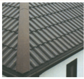
B 屋根材の接着
