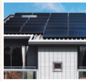
D 屋外隙間充填(ソーラー架台)
