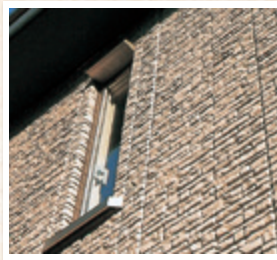
C 外壁材(サイディング等)、目地
